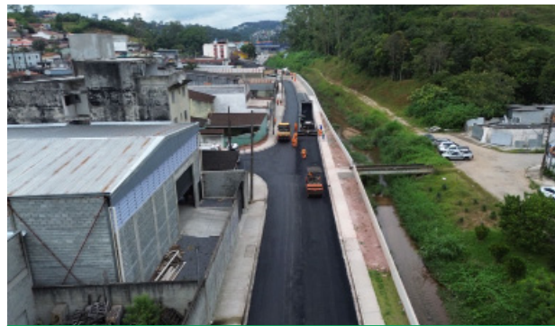
Asfalto já foi concluído. Foto: Fellipe Cruz (PMETRP)
