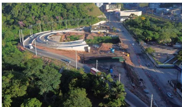
Canteiro de obra do Viaduto Estaiado. Foto: (PMETRP)
