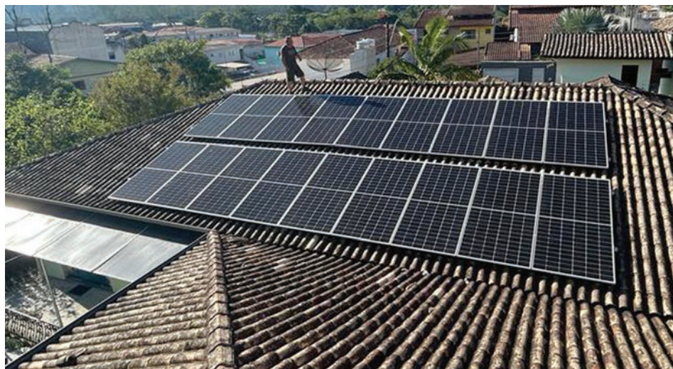
Painéis solares foram instalados em escola no Jardim Aymoré
