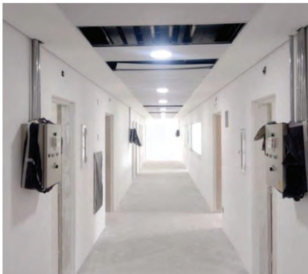
Hospital Santa Luzia se aproxima da conclusão
