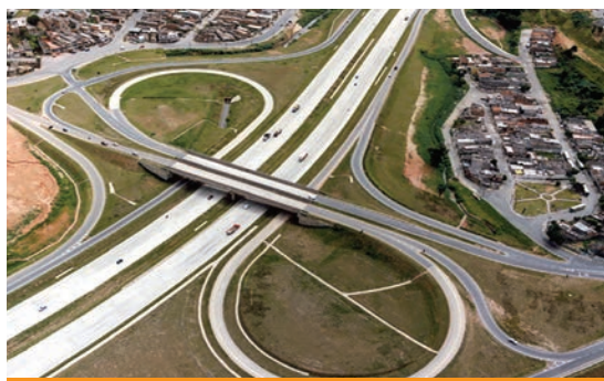
Instalação de pórtico causará interdição
